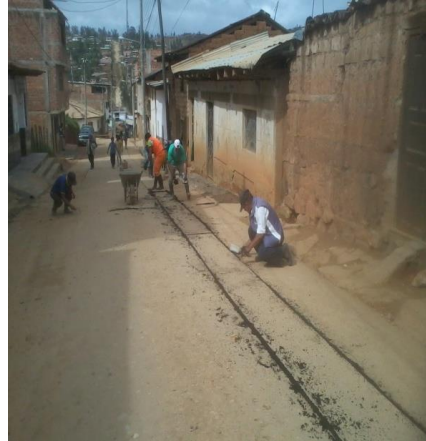
Colocación de junta asfáltica
