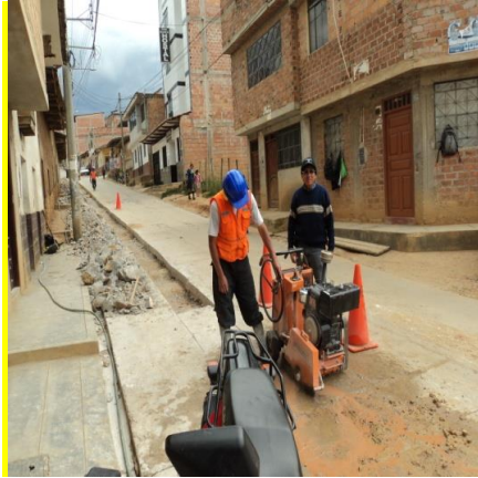
Corte y demolición de pista de concreto
