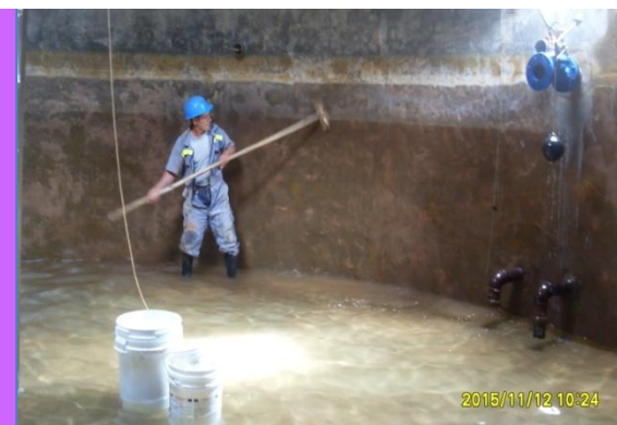
Mantenimiento: Caseta de bombeo Pedro Castro
