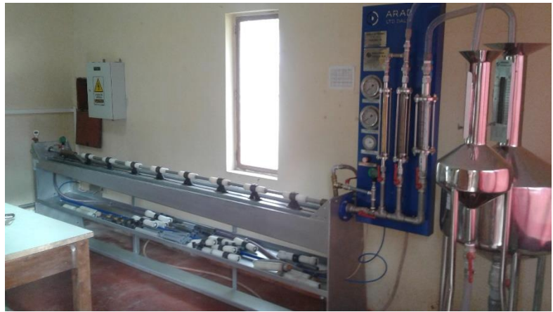
Banco de prueba de medidores
