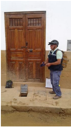
Cambio de medidor
