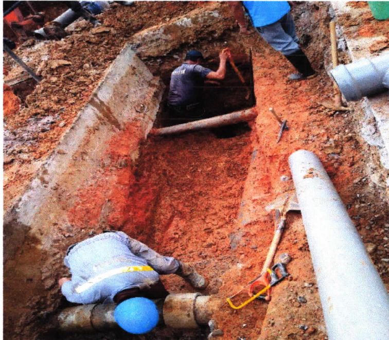
Reparación de Red de Agua Potable
