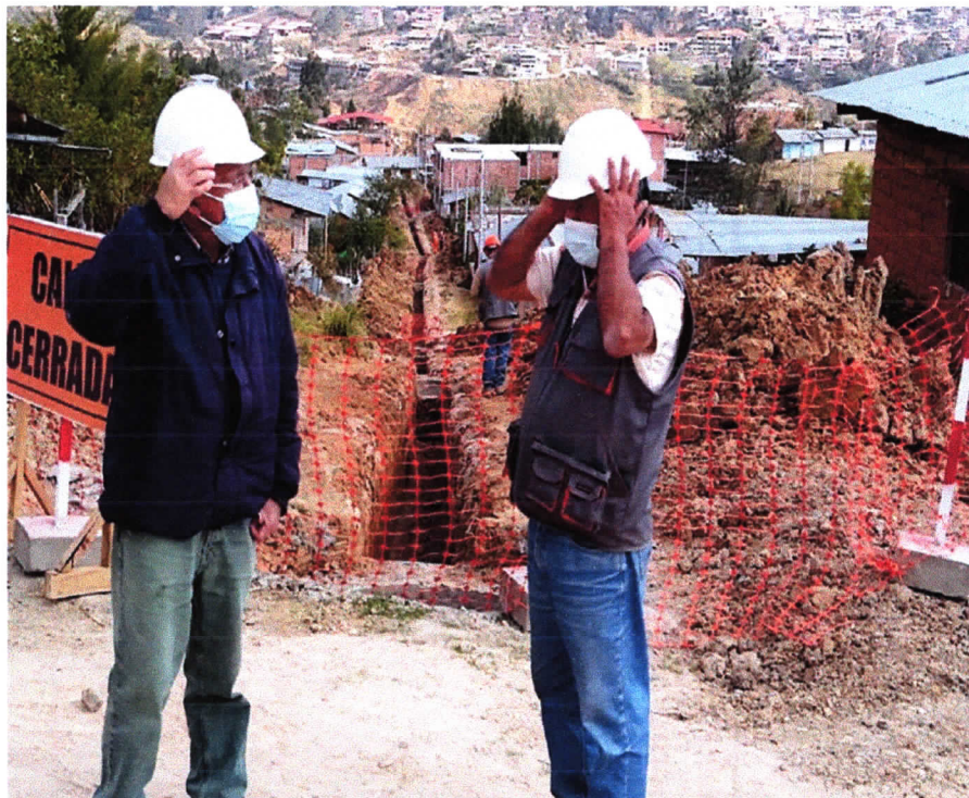
Ampliación de Redes de Agua y Alcantarillado
