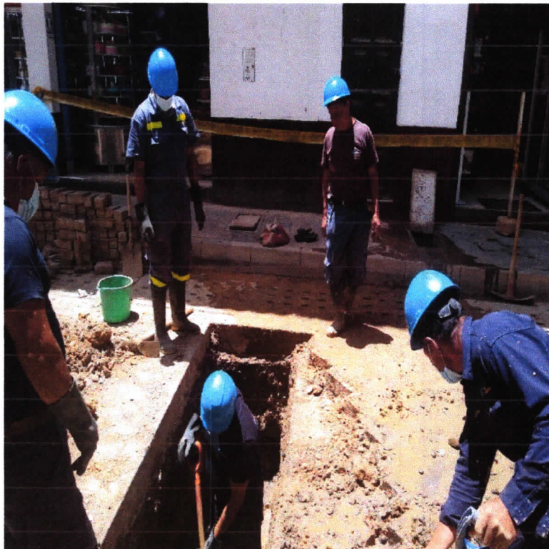
Reparación de Red de Alcantarillado
