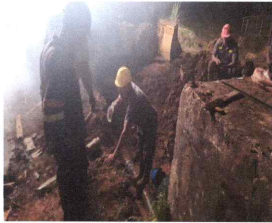
Reparación de la red primaria
