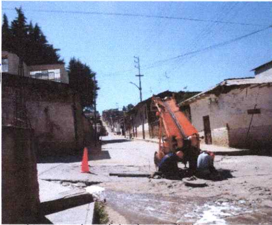
Limpieza de red de alcantarillado
