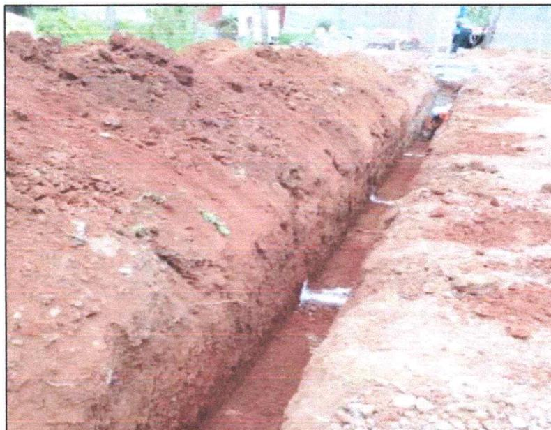
**Foto N° 02:** Refine y nivelación de fondo de zanjas para red colectora de alcantarillado en el sector Santa Isabel
