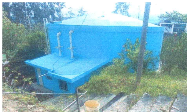
Reservorio R2 de 1000m3
