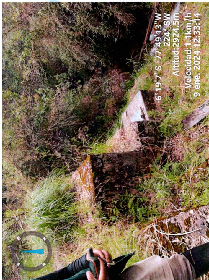
Imagen 17. Tubería y cámara rompe presión Conducción Tilacancha – Sector Condorkaka
