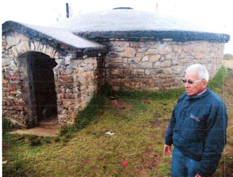
FOTO N° 10 VISTA DEL RESERVORIO R-3
